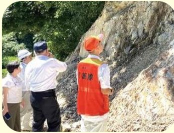
国有林道 豪雨災害現場視察 (舟形町)
